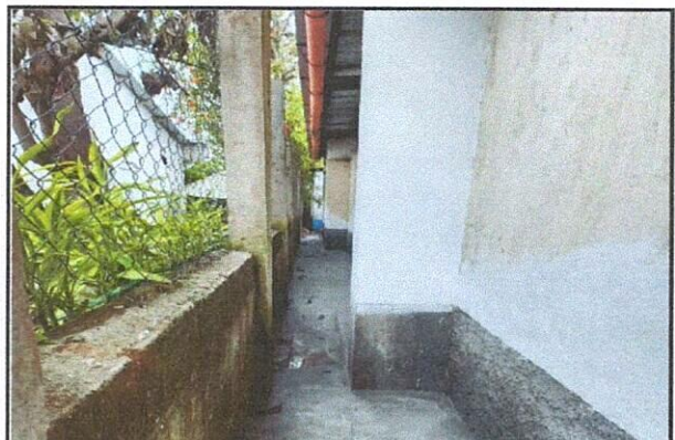
Foto 4: Resultado final del mejoramiento de paredes y cernido, banqueta de concreto y canal pluvial en el corredor posterior del centro educativo.
