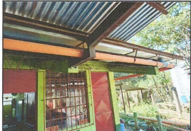
Foto 2: Instalación final del canal pluvial y tubería de bajada pluvial en corredor principal y posterior del centro educativo.
