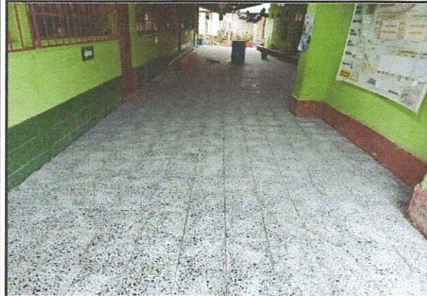
Foto 1: Piso de granito completo instalado en el corredor principal del centro educativo.
